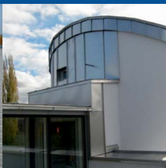
Krankenhaus Barmherzige Brüder, München
