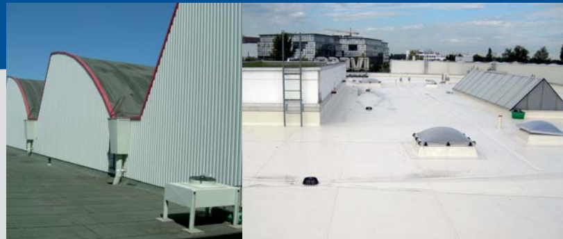
Bituminöse Abdichtung Voith Turbo GmbH & Co. KG Garching
